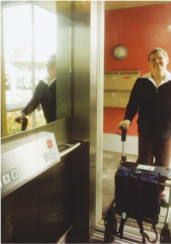
Barrierefreier Fahrstuhl mit großen, kontrastreichen Tasten und eingebautem Spiegel
