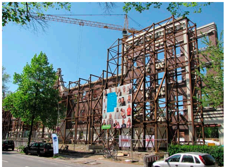
In dem neu entstehenden Quartier Bethanien werden unterschiedliche gemeinschaftliche Wohnformen umgesetzt.
