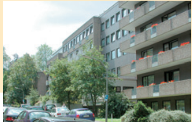
Straßenansicht vor der Modernisierung
